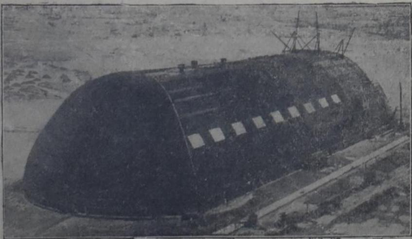
res, cada uno de los cuales pesa 620 toneladas. Sostiene en dichos arcos el techo, que es de láminas de acero. El arco del centro está unido permanentemente a sus cimientos, y los demás están montados en rodillos. Estos rodillos corren sobre rieles y permiten la expansión y contracción termal de la colosal masa de acero en todas direcciones. Como 39 centímetros de diferencia habrá en el largo del edificio entre la más baja temperatura del invierno y la más alta del verano.
